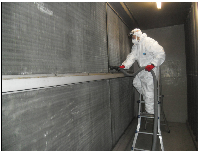
Asportazione meccanica delle polveri presenti all'interno dei pacchi alettati.
